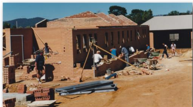
Parafianie na placu budowy | wszystkie zdjęcia Tadeusz Mierzanowski
