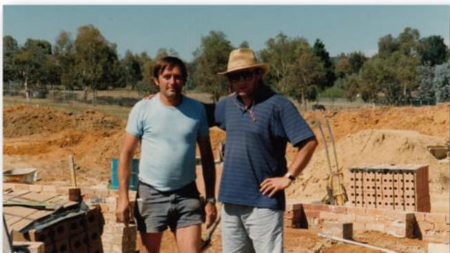
Od lewej: Adam Pilarzski i ks. Tadeusz Przybylak na placu budowy
